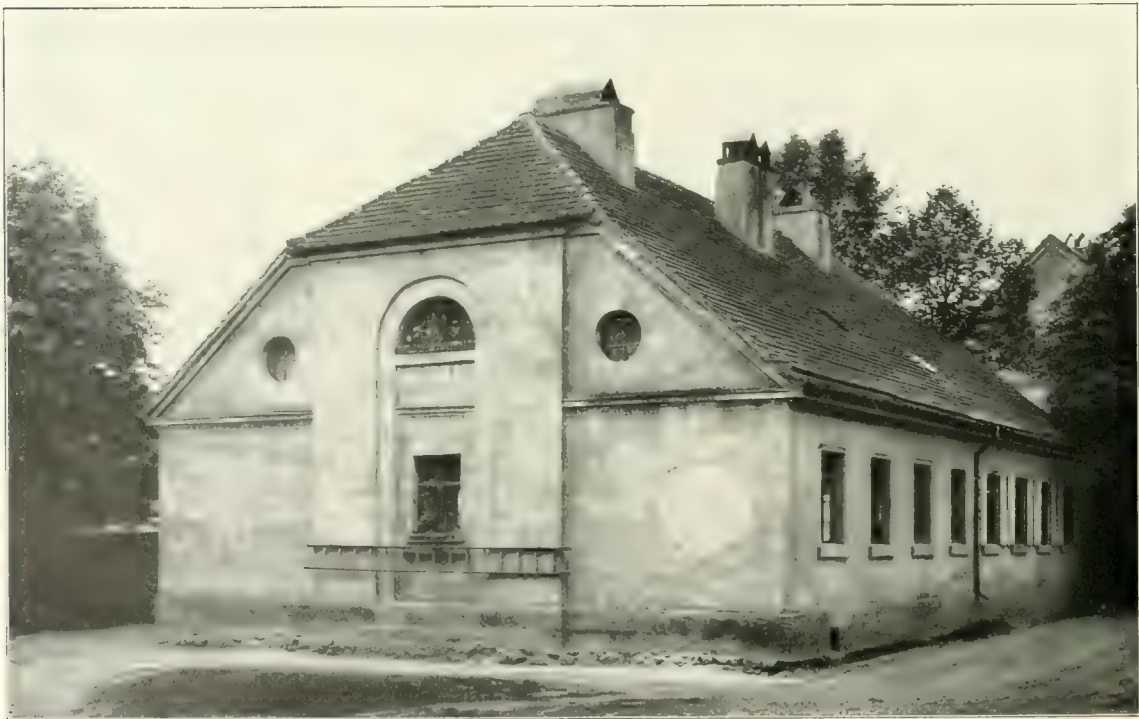
Arbeiterwohnhaus in Eberswalde Kupferhammer. Anfang 19. Jahrhunderts.
